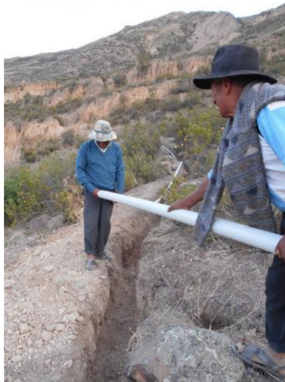
Figur 2 Grøfter blir gravd for hånd og på dugnad.
